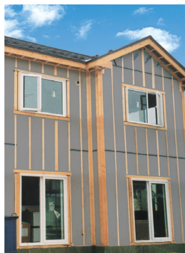
カネライトフォーム®スーパーEX 外張り断熱施工例
